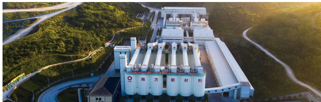
湖南临澧南方新材料采用无尘中深孔微差爆破实现零污染零排放
