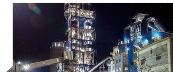
中材节能南通万达钢厂烧结机余热发电锅炉项目
