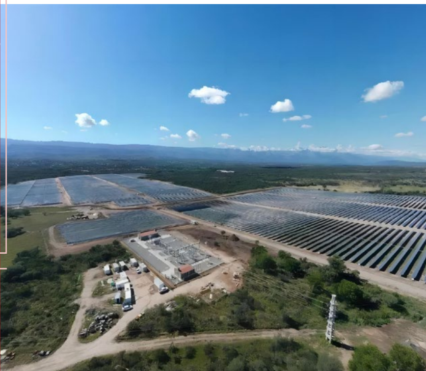
中国建材工程总承包建设的阿根廷科尔多瓦省库拉布罗切罗30兆瓦光伏电站，该项目是中国建材集团在南美地区的首个光伏电站项目
