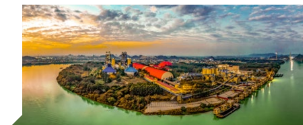
广西金鲤水泥厂协同处置周边火电厂、钢铁厂等产生的工业废物
